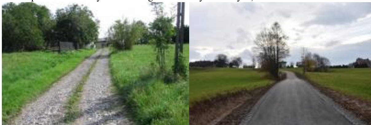
Zdjęcie 4. Droga – ul. Stroma w Kisielowie przed i po remoncie Wykonane przez Referat Promocji Gminy.
