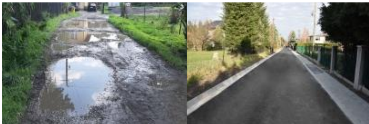
Zdjęcie 3. Droga – ul. Jana Ożany w Cisownicy przed i po remoncie Wykonane przez Referat Promocji Gminy.
