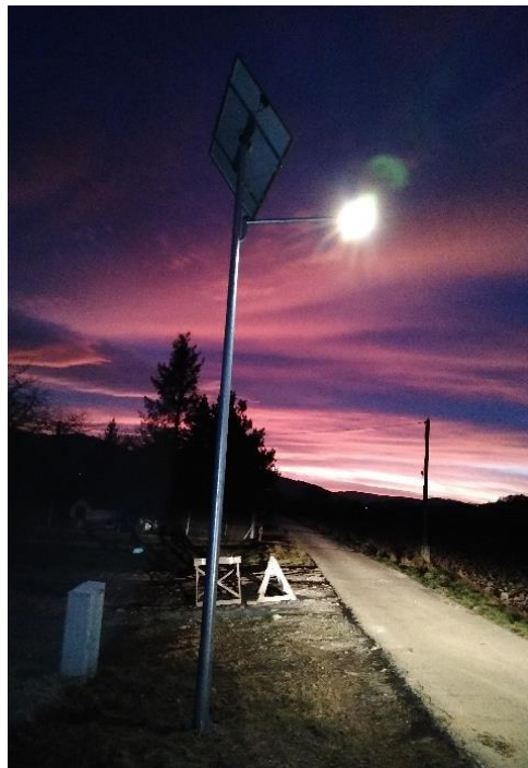
Zdjęcie 1. Lampa solarna w Goleiszowie Równi
