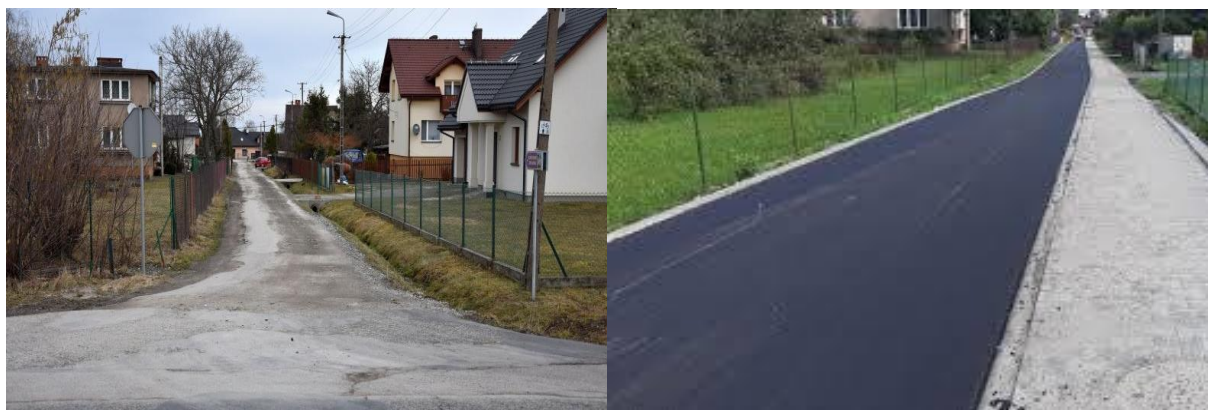
Zdjęcie 2. Droga – ul. Osiedlowa w Goleszowie Równi przed i po remoncie Wykonane przez Referat Promocji Gminy.
