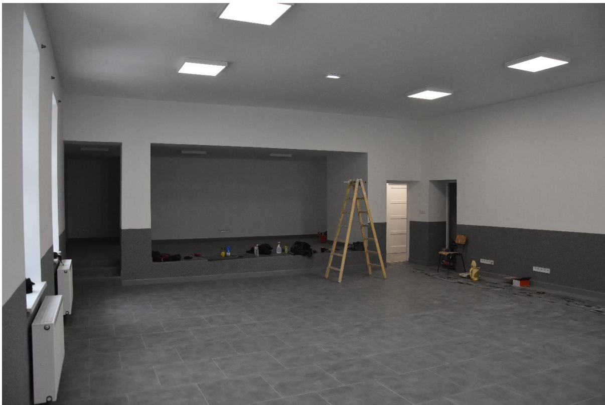
Zdjęcie 20. Pomieszczenie Klubu Seniora w Cisownicy w trakcie remontu Źródło: Urząd Gminy Goleiszów.
