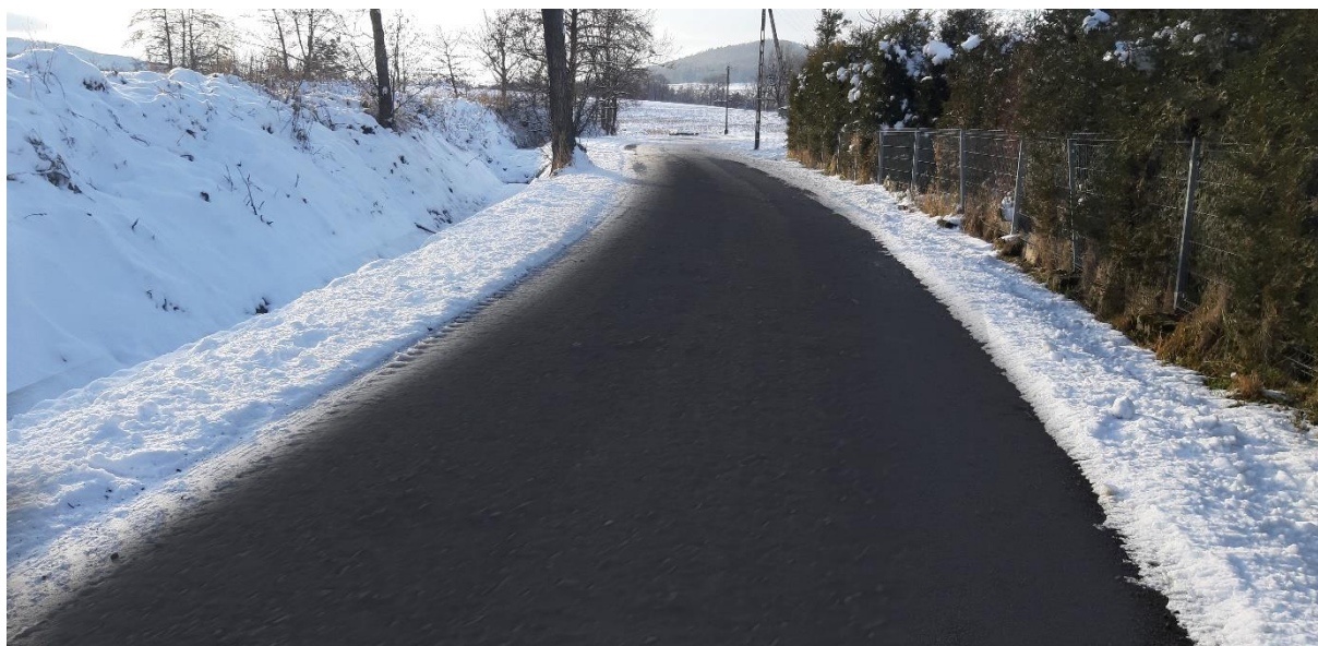
Zdjęcie 6. Zmodernizowana ulica Nierodzimska w Godziszowie
