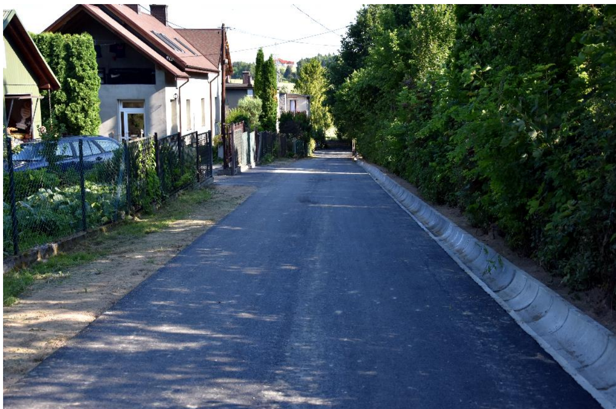
Zdjęcie 7. Zmodernizowana ulica Mostowa w Goleiszowie
