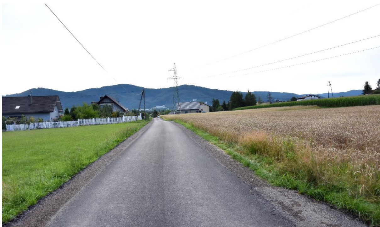
Zdjęcie 9. Zmodernizowana ulica Orzechowa w Goleiszowie Równi Źródło: Urząd Gminy Goleiszów,
