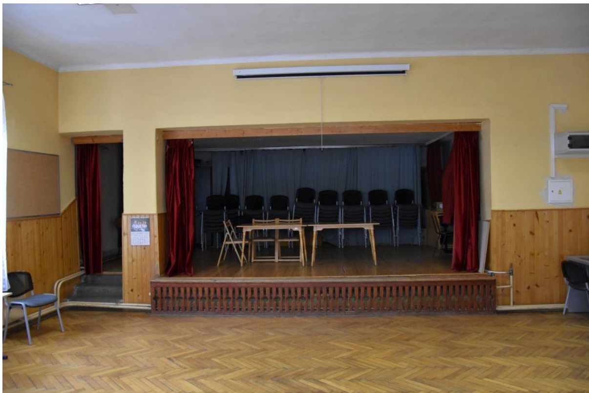
Zdjęcie 19. Pomieszczenie Klubu Seniora w Cisownicy przed remontem Źródło: Urząd Gminy Goleszów.
