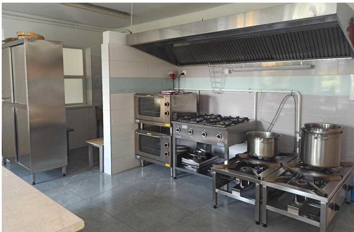
Zdjęcie 29. Kuchnia w Szkole Podstawowej w Dzięgielowie po remoncie Źródło: Urząd Gminy Goleszów.
