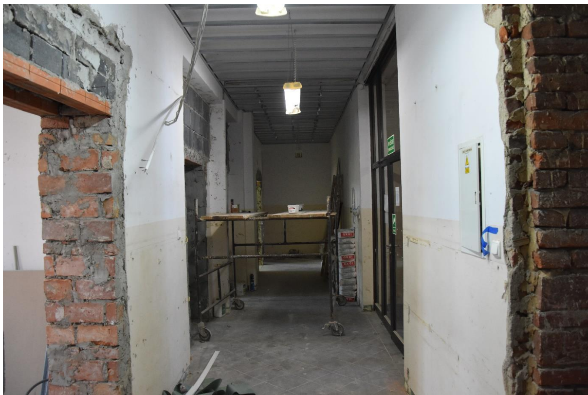
Zdjęcie 22. Pomieszczenia przyszłego Centrum Usług Społecznych w trakcie remontu Źródło: Urząd Gminy Goleszów.
