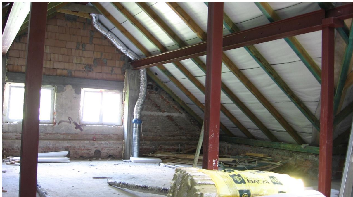
Zdjęcie 23. Remontowane poddasze Transgranicznego Centrum Szkolenia Strażaków Źródło: Urząd Gminy Goleiszów.
