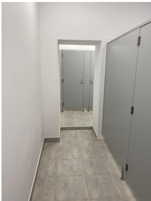
Zdjęcie 21. Wyremontowane toalety w przyszłym Klubie Seniora w Dzięgielowie Źródło: Urząd Gminy Goleiszów.
