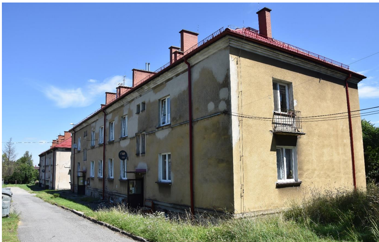
Zdjęcie 14. Bloki w Cisownicy przed modernizacją
