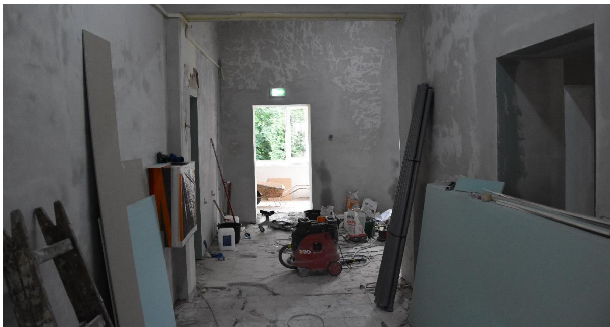
Zdjęcie 25. Remont pomieszczeń Przedszkola Publicznego w Cisownicy
