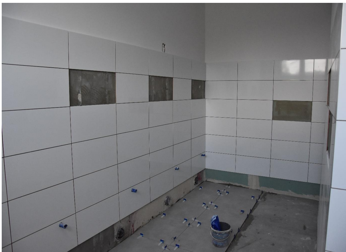
Zdjęcie 27. Sanitariaty w Przedszkolu Publicznym w Puńcowie w trakcie remontu Źródło: Urząd Gminy Goleszów.
