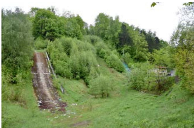
Zdjęcie 52. Skocznia w Goleiszowie. Źródło: UG Goleiszów.
