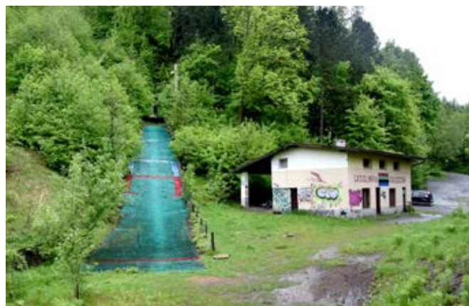
Zdjęcie 51. Skocznia w Goleiszowie. Źródło: UG Goleiszów.
