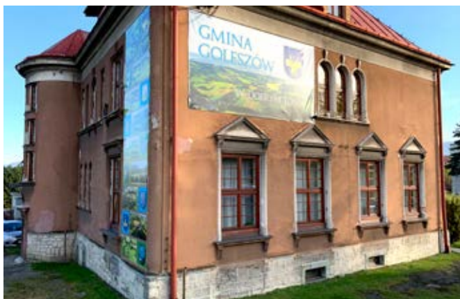
Zdjęcie 50. Budynek Urzędu Gminy w Goleiszowie. Źródło: UG Goleiszów.
